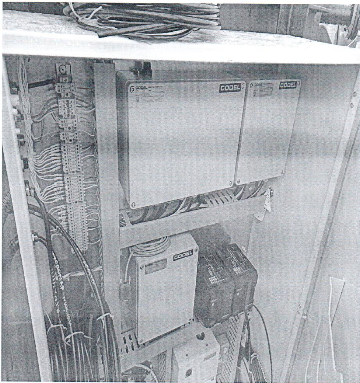
Рисунок 1.1 – Фотография общего вида шкафа газового анализа АСКВ
