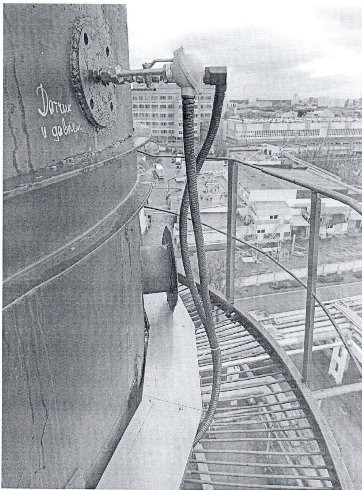
Рисунок 1.8 – Фотография общего вида дымовой трубы. Преобразователь давления измерительный РС-28 и преобразователь температуры CTR-6
