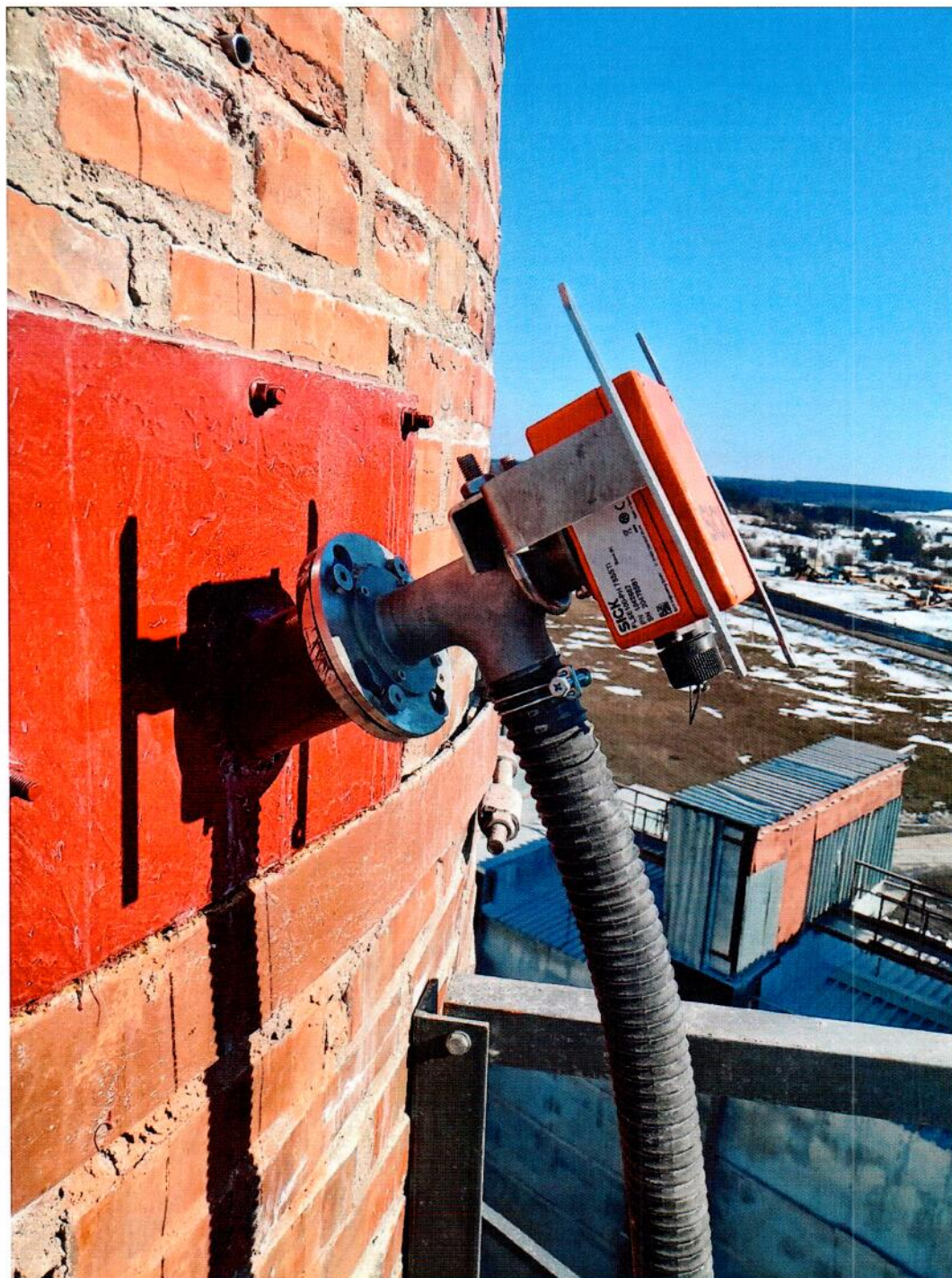
Рисунок 8 – Фотография дымовой трубы. Измеритель скорости ультразвуковой Flowsic100 H
