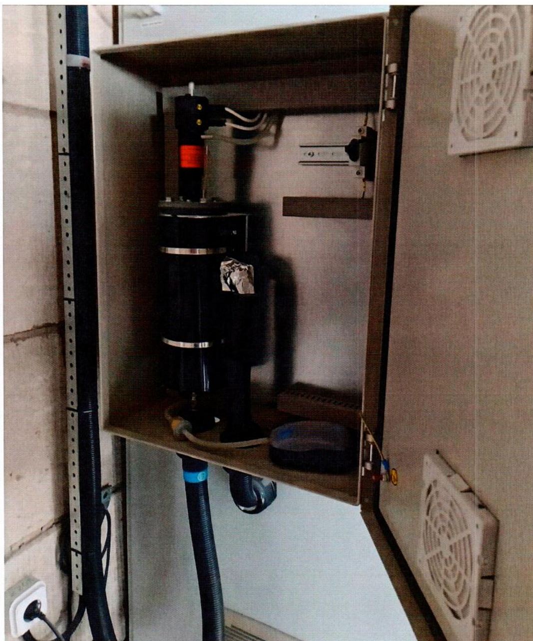
Рисунок 3 – Шкаф газового анализа АСКВ. Анализатор кислорода ТДК-3М
