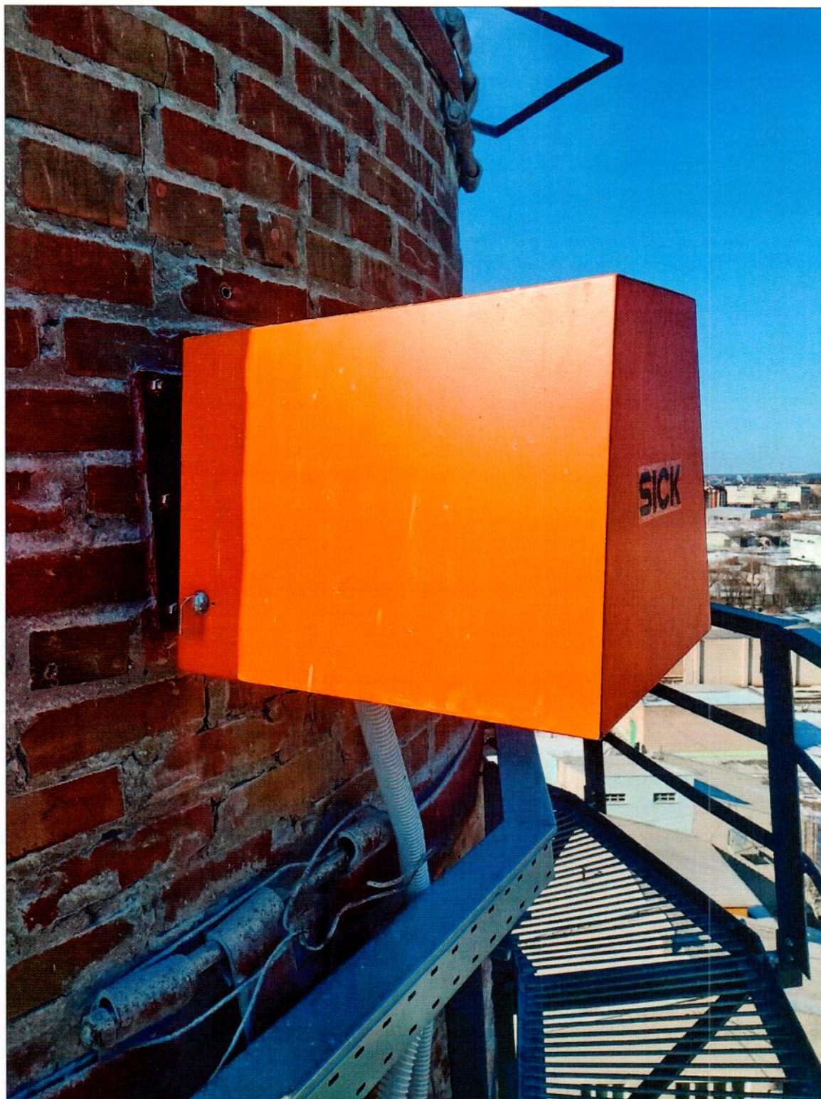
Рисунок 10 – Фотография дымовой трубы. Анализатор пыли Dusthunter T100
