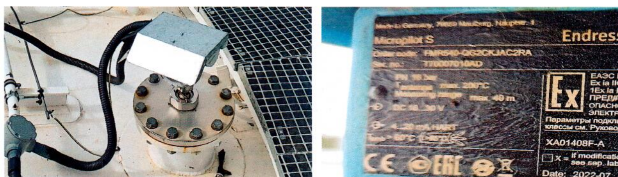
Рисунок 1.3 – Внешний вид и образец маркировки уровнемера микроволнового Micropilot из состава системы (изображения носят иллюстративный характер)
