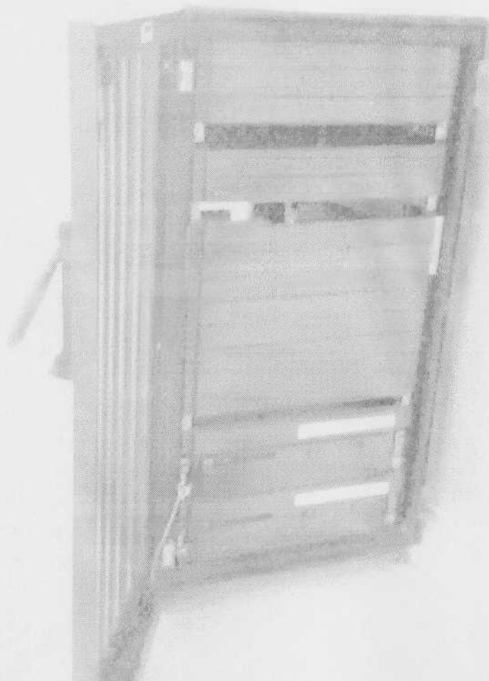
Рисунок 1 – Внешний вид АПУС ATC Alcatel 1000S12 EEW1A
