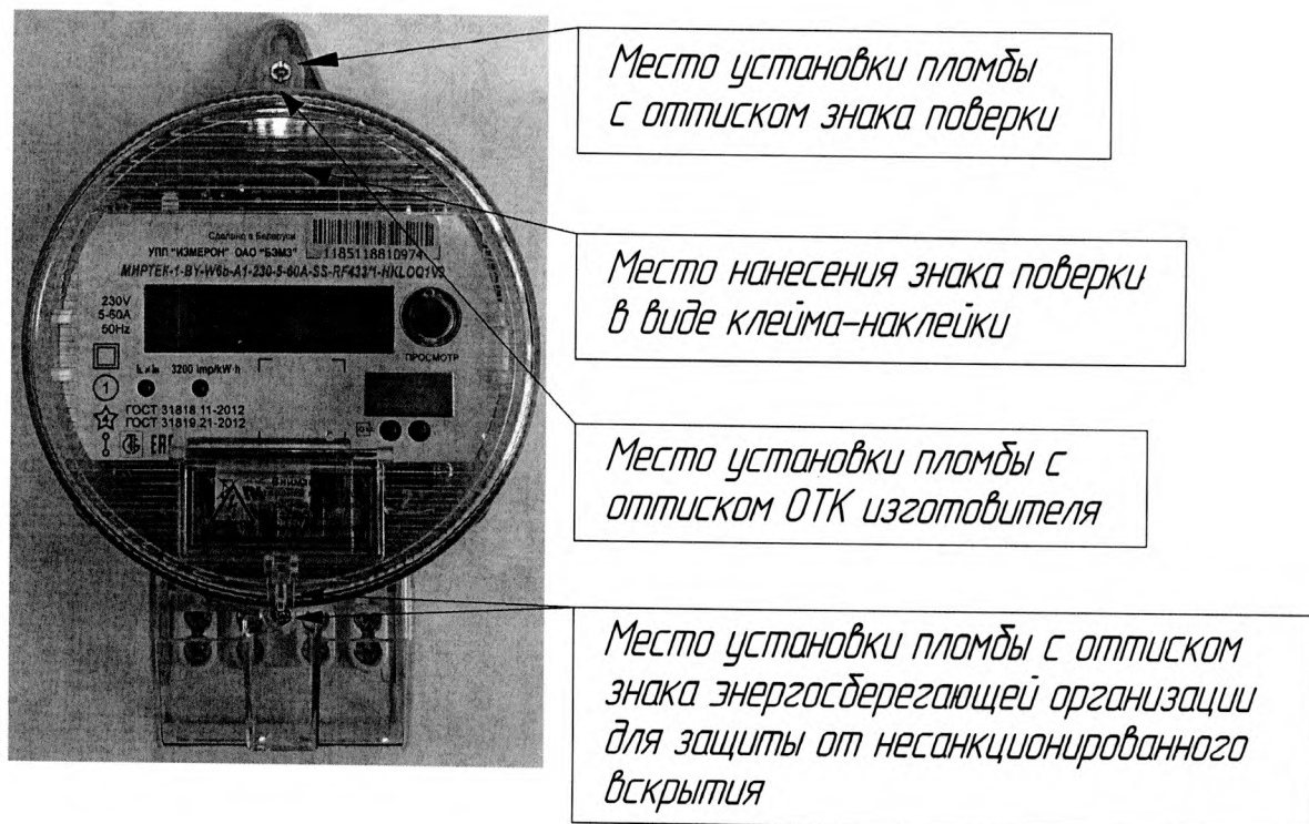
Рисунок А.4 – Места установки пломб и нанесения знака поверки для счетчиков в корпусе модификации W6b
