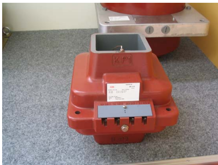
Рисунок 3 – Трансформатор тока измерительный проходной ВВ.
