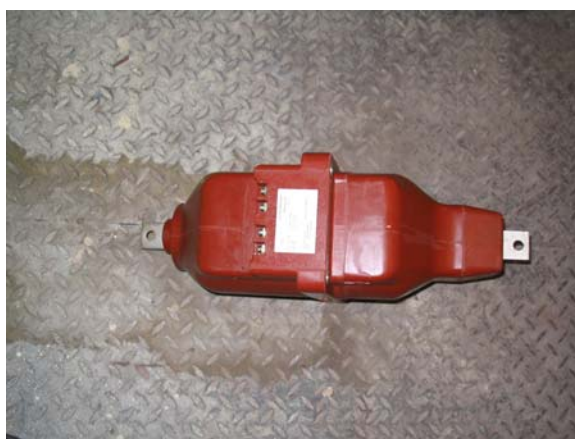
Рисунок 2 – Трансформатор тока измерительный проходной TSR.
