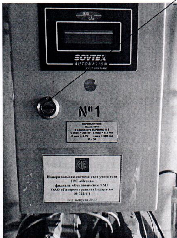
Рисунок 3.1 – Схема пломбировки от несанкционированного доступа
