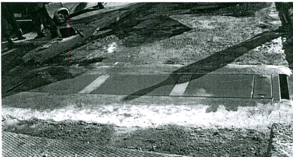
Рисунок 1 — Общий вид ГПУ для взвешивания ТС по частям в движении (пример)
